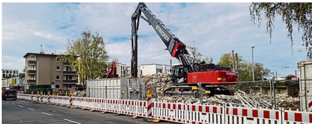
Abrissarbeiten an der Scheidtweilerstraße für das Wohn-Quartier
